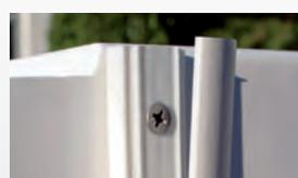
Anschluss der PVC-Auskleidung mit Klemmleiste für Folientank.
